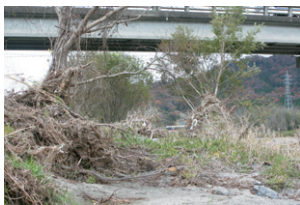
甲西大橋下の堆積、流木等！
